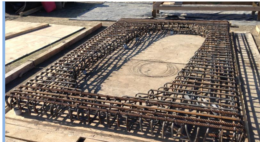
Enfierradura consola de apoyo
